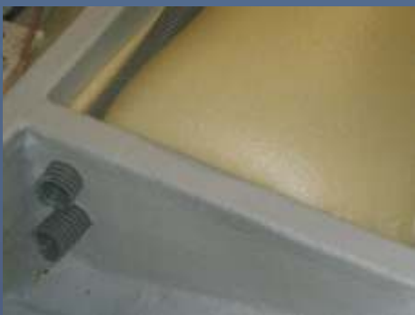
Kabelkanäle zwischen den Schotten eingeschäumt Cable channels foam embedded between the Stringer
